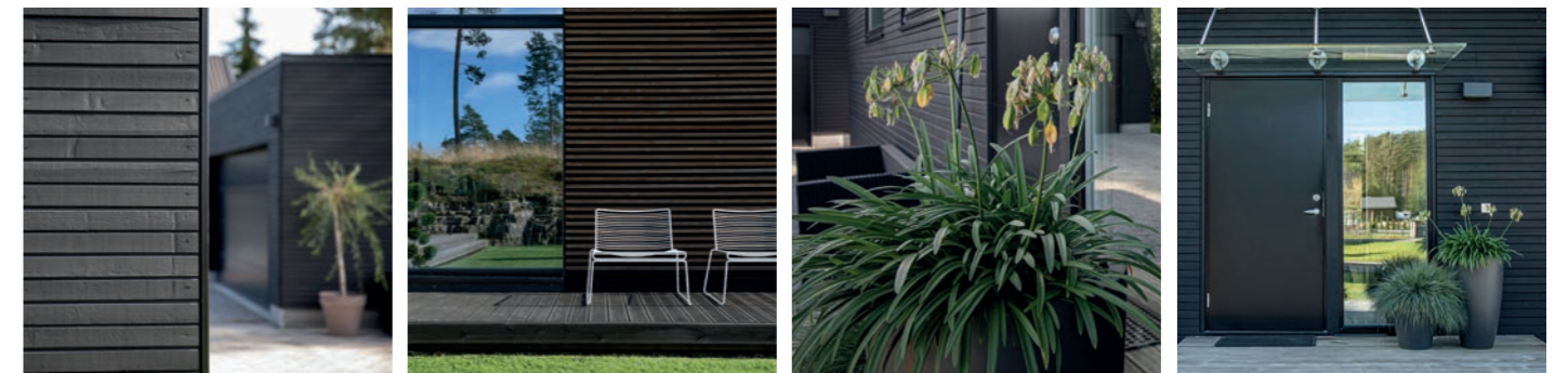
Spilene på veggene er beiset med Butinox Oljebeis i fargen 521 Teak. De transparente tredetaljene gir en spennende kontrast til de malte veggflatene.
