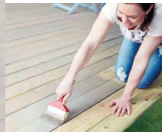
Beisen er enkel å påføre. Kun ett strøk!
